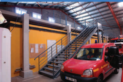
Aménagement de l'étage et création de l'escalier
