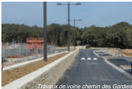
Travaux de voirie chemin des Gardies
