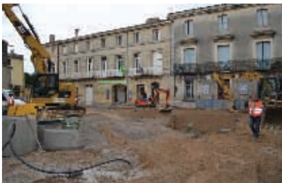
La place Verdier pendant les travaux
