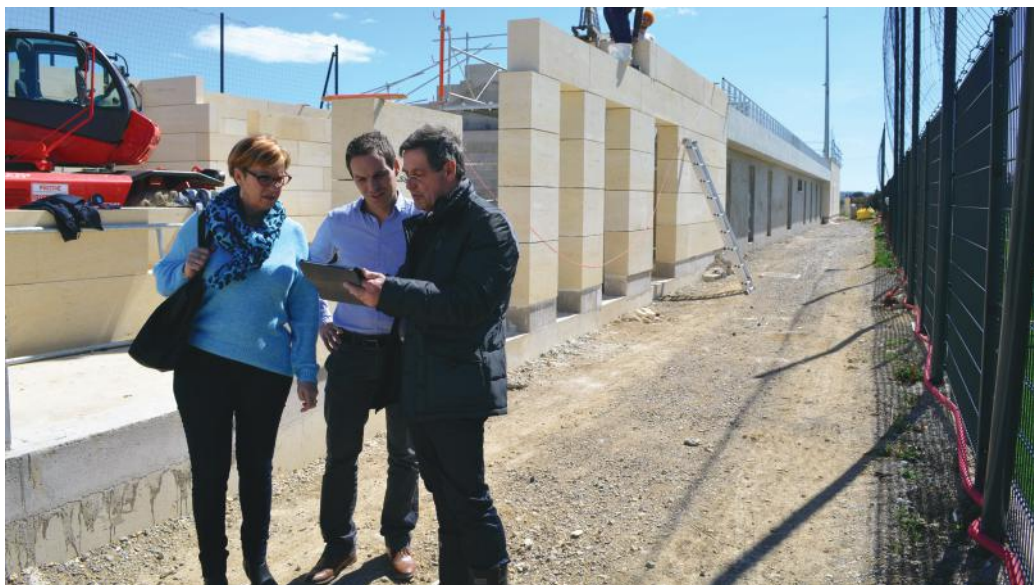
Madame le Maire, Michelle Cassar, Christophe Desprats (DGS) et Denis Galinier (adjoint à l'urbanisme) sur le chantier des tribunes
