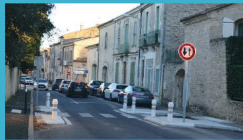
Aménagement voirie et espace public en partenariat avec la Métropole de Montpellier
