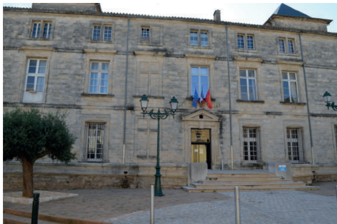
Des travaux de rénovation énergétique sont entrepris dans certains bâtiments communaux
