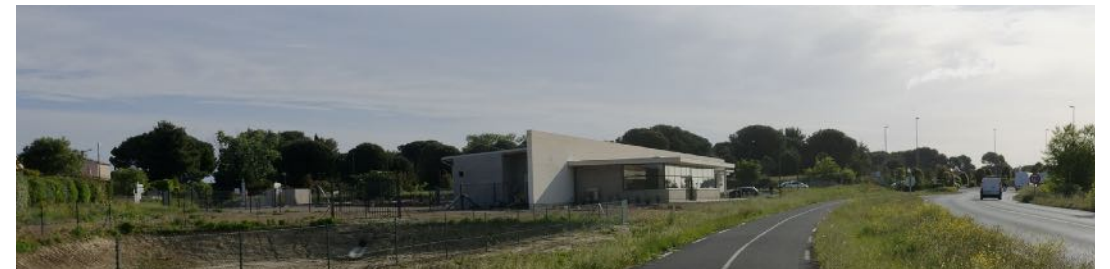
L'Impact de la nouvelle cave oléicole en vitrine sur la RD5
