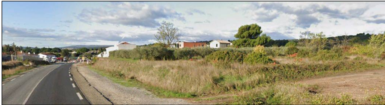
VUE 02 : Le nouveau quartier St Estève depuis la RD5 E5.
